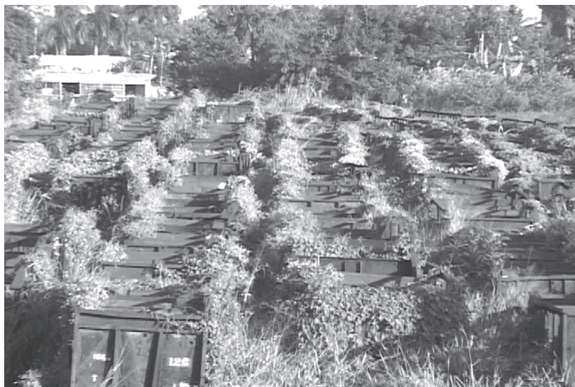
Ruinas de los vagones del Ingenio Consuelo. Fuente AGN.
