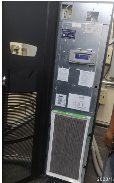
3. Un UPS del área de Seguridad marca Eaton de 10 kva, modelo 9155
