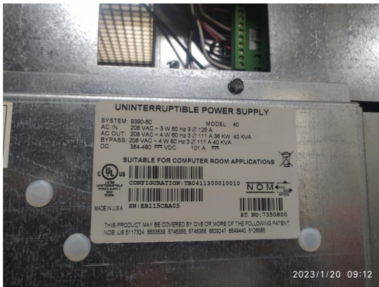
2. Eaton de 40 kva, modelo powerware 9390:
