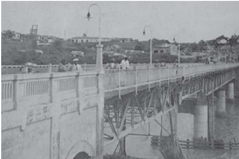
Puentes Levadizo "Ulises Heureau", construido sobre las bases del antiguo Puente Ozama (de 1878). Se terminó en el período 1914-1917. Este puente fue seriamente dañado por el ciclón de San Zenón en 1930. En ese mismo lugar fue construido el puente Ramón Matías Mella, inaugurado en 1976 por el presidente Joaquín Balaguer. (Fototeca AGN, Álbum Sócrates Solano)
