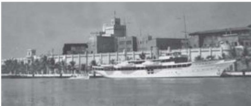
Puerto de Santo Domingo construido durante el gobierno de Rafael L. Trujillo. Al fondo, la antigua Fortaleza Ozama y la entrada principal de la que fue conocida como Fortaleza Trujillo en la margen occidental del río Ozama. Frente a la fortaleza cruza la avenida Francisco Alberto Caamaño Deñó. (Fototeca AGN, Arquitectura y Paisaje Dominicano, 12-10-fol. 298).
