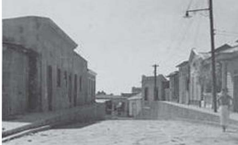
Calle Hostos, designada con ese nombre el 15 de marzo de 1904 por iniciativa del historiador Bernardo Pichardo y en homenaje al educador puertorriqueño Eugenio María de Hostos. La foto recoge el segmento de la calle próximo al convento e iglesia de San Francisco. (Fototeca AGN)
