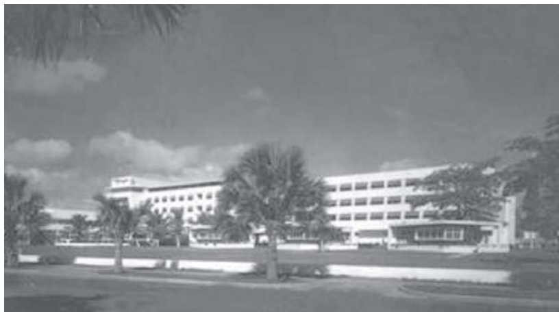
Antigo Hotel Jaragua, inaugurado el 17 de agosto de 1942. Su demolición en 1985 dio paso a la construcción de un nuevo hotel, inaugurado en noviembre de 1987. (Fototeca AGN, Arquitectura y Paisaje Dominicano, 12-10-fol. 186)
