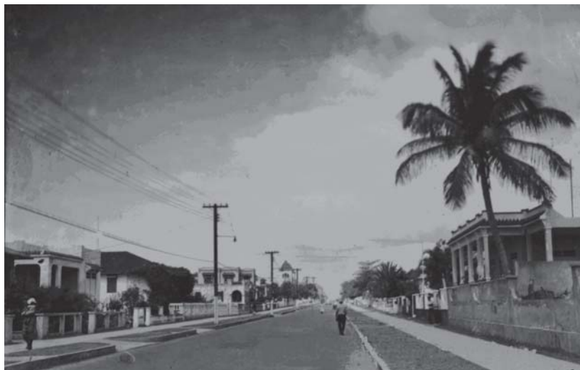
Avenida Bolívar. Al fondo a la izquierda, el edificio de la Legación Americana, ubicado en la esquina sureste con la calle Doctor Delgado. (Foto: AGN. Fondo Luis Mañón)
