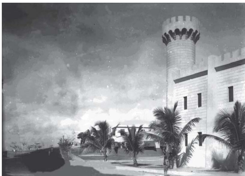
Una vista más al oeste de la avenida U. S. Marine Corps. En primer plano, a la derecha, parte de la muralla construida alrededor de la Fortaleza Ozama durante la dictadura de Trujillo. (Fototeca AGN)
