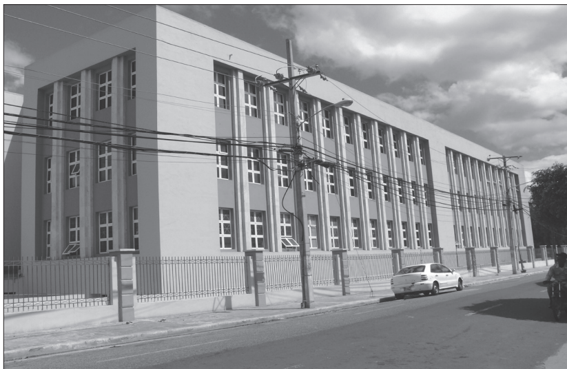
Exterior del nuevo edificio del AGN desde la calle Hermanos De la Maza.
