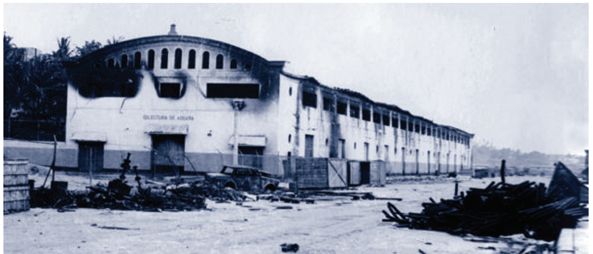
Edificio de la Colecturía de Aduanas. Fuente: Fototeca, AGN.
