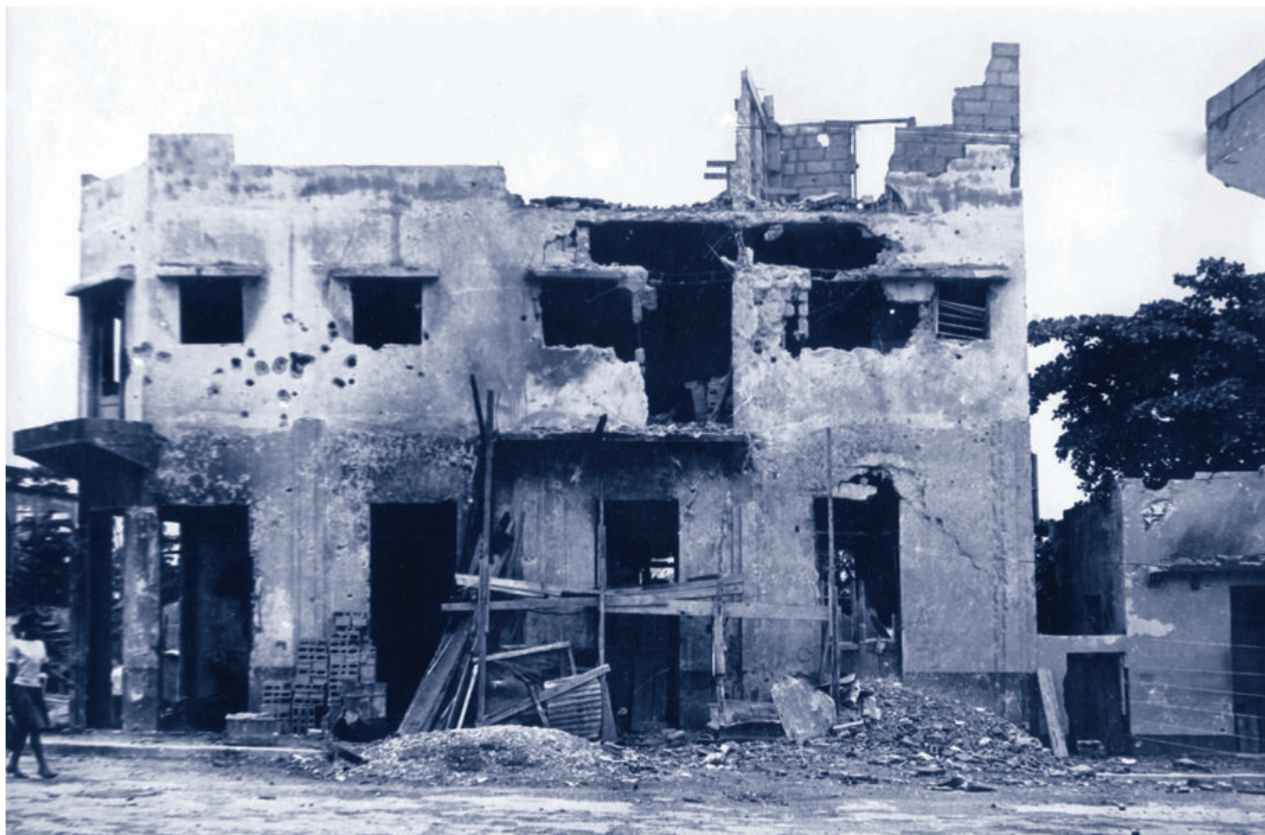
Edificación visiblemente afectada por balas y bombas. Fuente: Fototeca, AGN.
