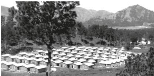
Efectos devastadores dejó el paso del ciclón David por la isla de Santo Domingo el 31 de agosto de 1979, cuya entrada se produjo entre las provincias de San Cristóbal y Peravia, con categoría 5 y vientos de 240 km/h que no cesaron durante cuarenta y ocho horas. Cuatro días después azotó la tormenta Federico con vientos de 135 km/h, cuyas aguas se prolongaron por seis días y terminó destruyendo lo poco que había dejado David en pie. Ambos ocasionaron miles de personas muertas y más de doscientos mil sin hogares, lo que motivó que en Constanza, en 1981, se construyeran estas viviendas para albergar refugiados, ubicadas en la margen norte de El Gajo, barrio al que se le nombro Villa Pinales.
