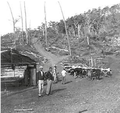
Manuel Alcides (Yango) Peguero Durán y Amador (Amado) Peguero en su aserradero de Pinar Parejo. Detrás, a la izquierda, una de las casetas donde estaban las máquinas que eran movidas con una planta diesel. La sierra tenía unos seis pies de diámetro y un gran espesor que hacía que se produjera una gran cantidad de desperdicios. A la derecha, las yuntas de bueyes que sacaban de los montes los pinos talados hasta los chuchos de carretera, donde eran subidos en camiones. 1966.
